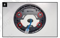
Verwenden Sie die mitgelieferten Dübel, um die Bodenplatte so zu befestigen, dass die ankommende Verkabelung mittig ist.
